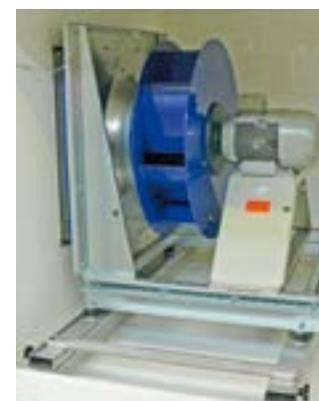
Fan motor assembly
